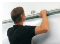
Die Rastschienen in die oberen Wandhalter einführen und einrasten.
