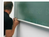
Durch hoch- bzw. herunterdrücken der Kederprofile wird das Gewebe gespannt.
